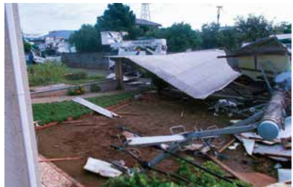
突風の影響による建物倒壊(坂戸市)
