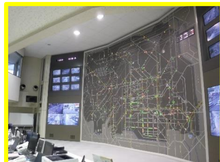
交通管制センター
