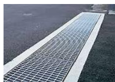
グレーチング (側溝のふた)
