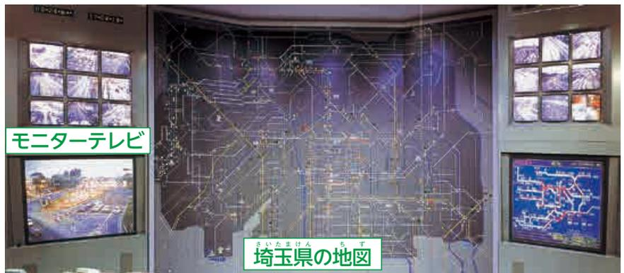
県内主要地域の信号機とセンター内のコンピュータを直結させて、複雑に変化する交通量に応じたきめ細かい信号機の制御を行うことで交通渋滞の解消及び安全の確保を図っています。
