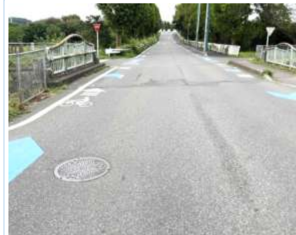
矢羽根型路面標示等車道混在型
